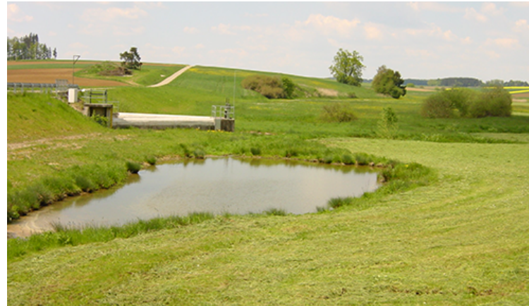
Umsetzung von Hochwasserschutzmaßnahmen
