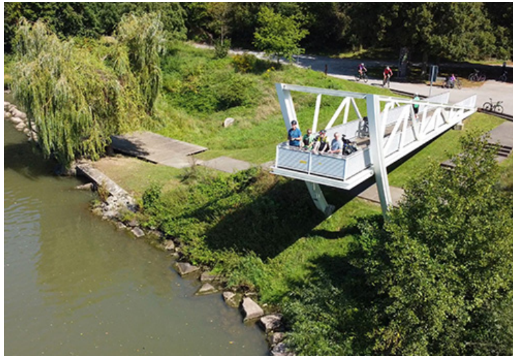
Landungsbrücke im Weidachtal
